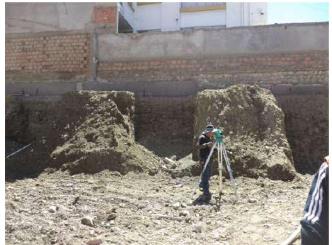
Imagen 8 Trazado y replanteo
