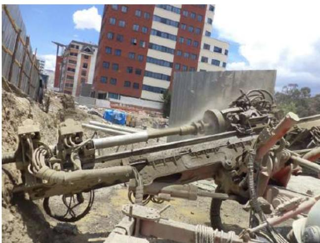
Imagen 10 Perforación de anclajes
