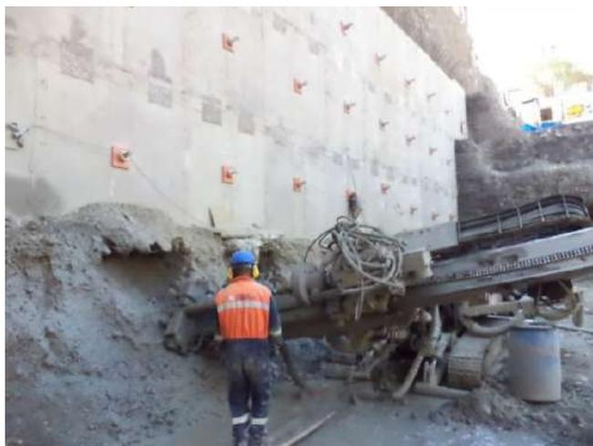
Imagen 2 Perforación e inyección
