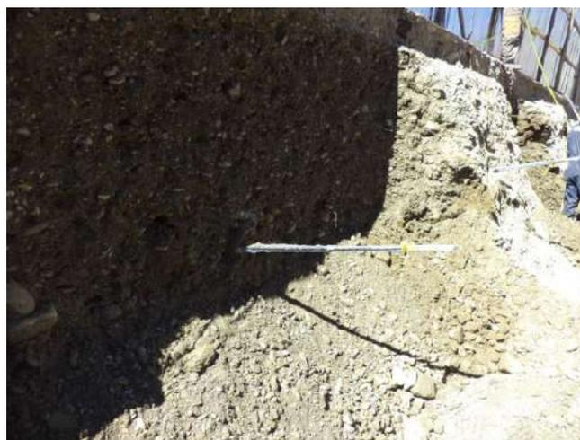
Imagen 12 Perfilado de excavación
