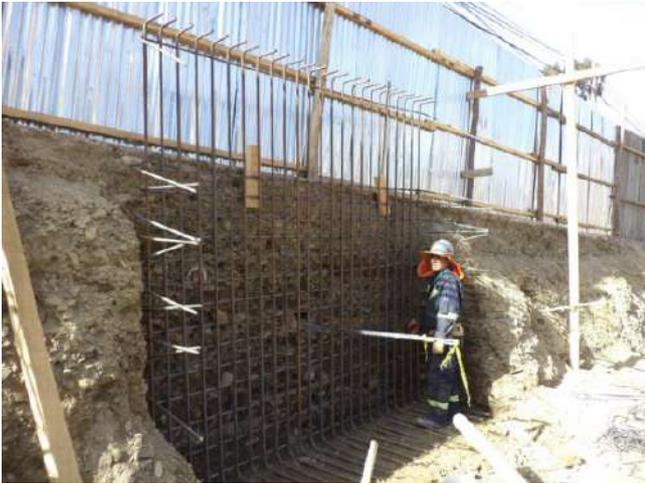
Imagen 13 Ejecución de muro de hormigón armado
