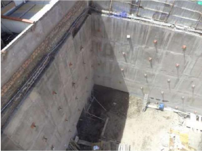
Imagen 16 Muros anclados en ejecución
